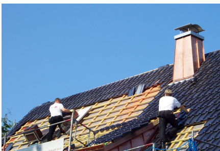
Dachsanierung in Sinsheim
